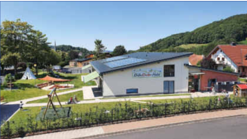
Die neue Kindertagesstätte RhönKinder-Haus mit Freigelände
