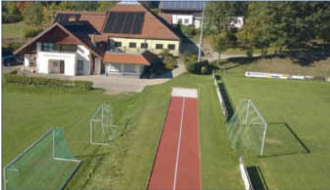
Die erneuerte Tartan-Anlaufstrecke zur Weitsprunggrube
