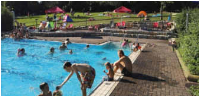
Freibad Poppenhausen: Bau einer neuen Sonnenterrasse. Investition: 20.000,-€
