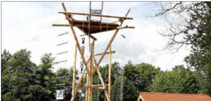
Neubau des Kletterturms „TEAM TOWER“ durch Pro-Impuls in 2011 Investition: 120.000,-€
